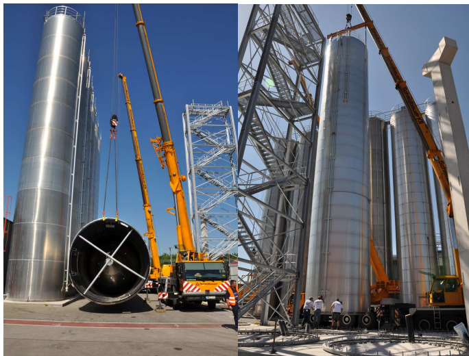
Montage van de nieuwe silo-installatie in de Salamanderfabriek in Türkheim.
